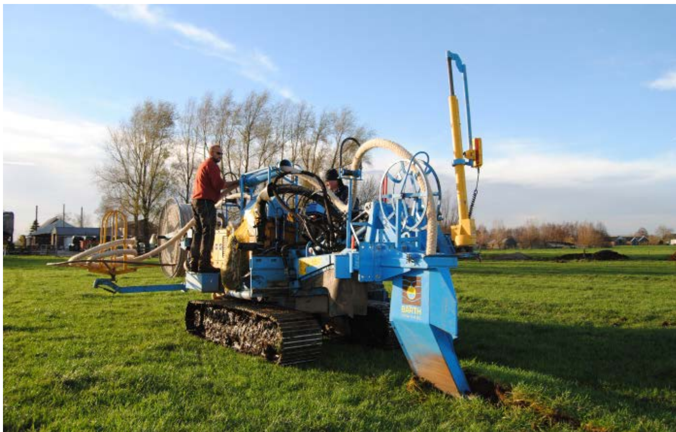
FOTO 1: SLEUFLOZE AANLEG DRAINAGE.
